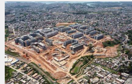
Contratante: Secretaria Municipal de Habitação de São Paulo – SEHAB/PMSP Obra: Programa Mananciais – Urbanização de Favelas, Construção de Unidades Habitacionais (São Paulo – SP)
