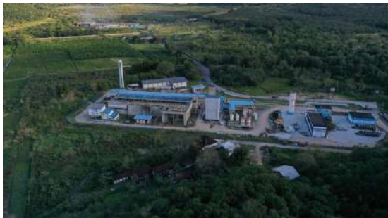
Contratante: Companhia de Saneamento Básico do Estado de São Paulo – Sabesp Obra: Sistema Produtor Mambu-Branco – 2ª Fase (Região Metropolitana da Baixada Santista, Itanhaém – SP)
