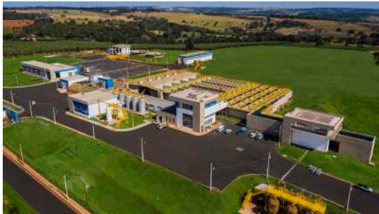
Contratante: Departamento Municipal de Água e Esgoto de Uberlândia – DMAE Obra: Novo Sistema Capim Branco – 1ª Etapa (Uberlândia – MG)
