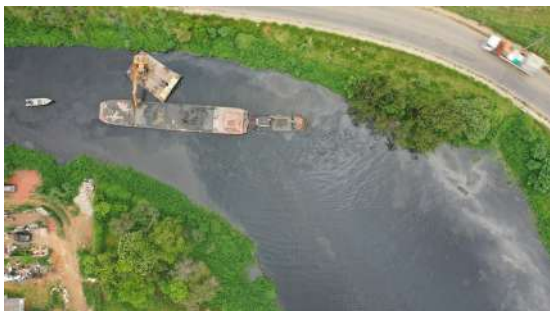
Contratante: Departamento de Águas e Energia Elétrica – DAEE Obra: Bacia do Alto Tietê – Obras para Combate às Enchentes (Região Metropolitana de São Paulo – SP)
